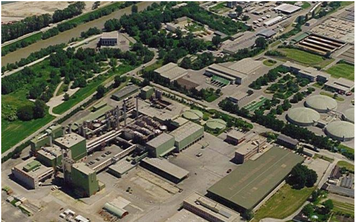
Abbildung 7: Werk Simmeringer Haide und Hauptkläranlage Wien
