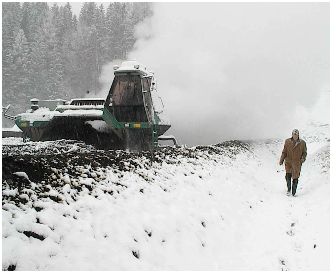
Abbildung 6: Wenden einer Restmüllmiets auf der Deponie Frohnleiten
