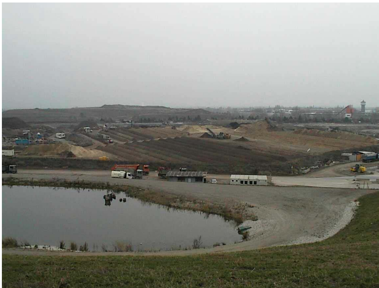
Abbildung 1: Anlage zur Herstellung von Erden aus Abfällen am Langen Feld
