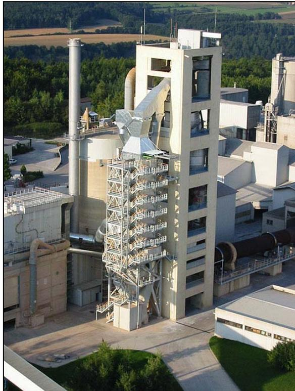
Abbildung 29: SCR Betriebsanlage im Zementwerk Solnhofen [SAUTER & SAMANT, 2003]
