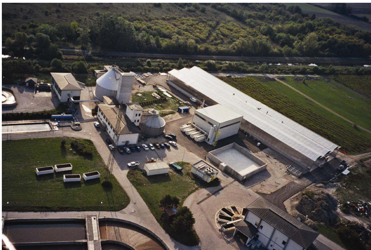
Abbildung 6: Erste Kalogeo Anlage in Österreich auf dem Gelände der Kläranlage Bad Vöslau/NÖ (Quelle: Tecon Engineering GmbH)
