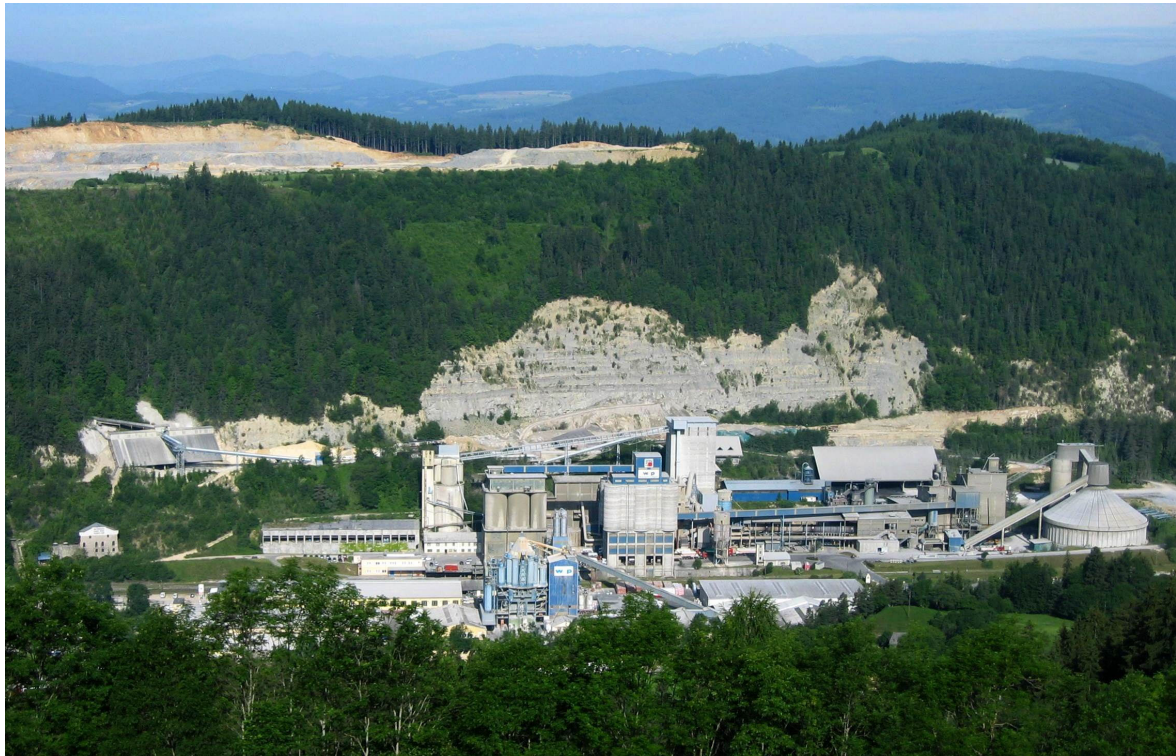
Abbildung 9: Wietersdorfer und Peggauer Zementwerke GmbH, Werk Wietersdorf
