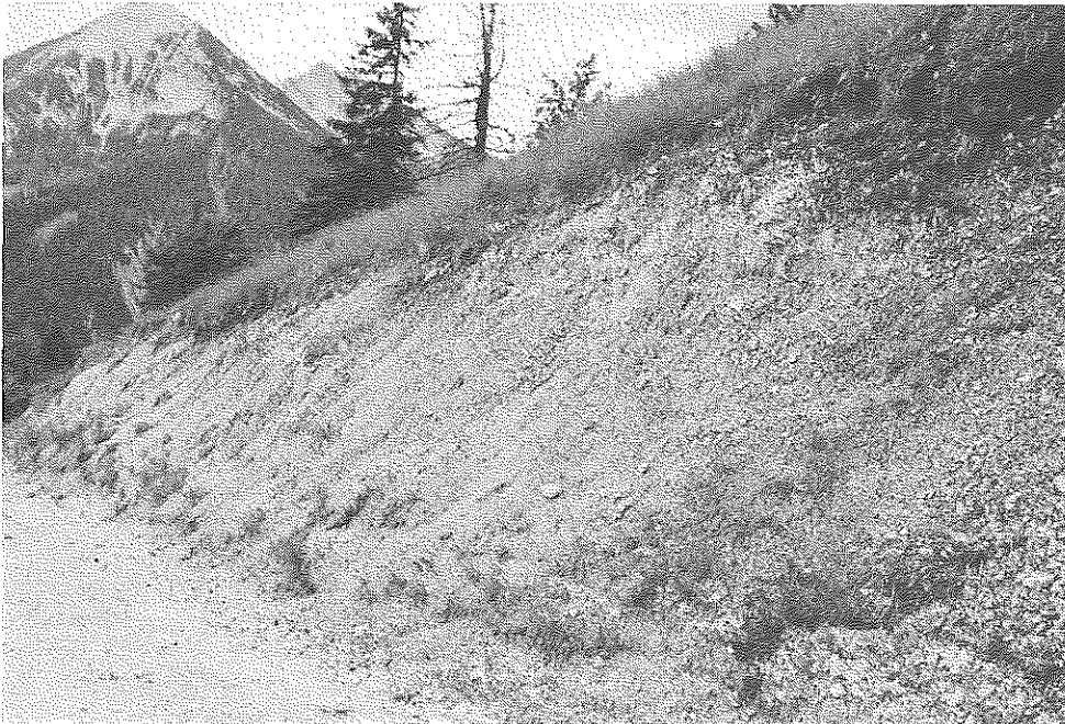
Abb.22: Vegetationslose, übersteilte Oberböschung des Weges zur Lawinenverbauung
