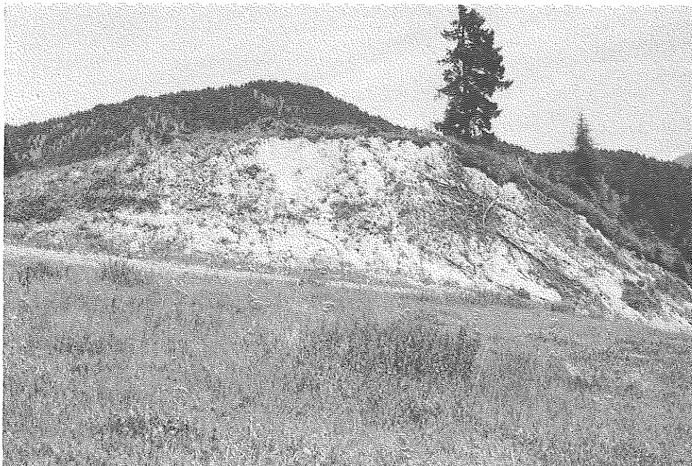
Abb.18: Vegetationslose Böschungen der Nordabfahrt
