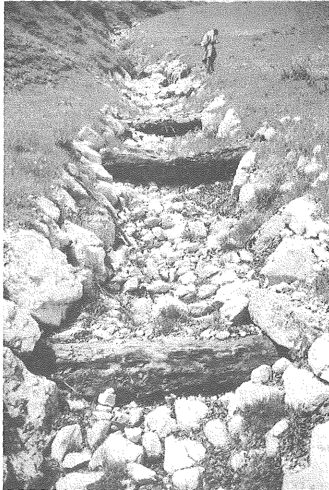
Abb.4; Mit großen Steinen ausgepflasterter und durch quergelegte Stammabschnitte gesicherter oberer Bereich des Gföllgrabenbaches bzw. Stodbaches
