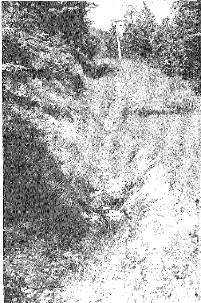
Abb.12: Längsentwässerungsgraben bei der Nordhang-Schlepplifttrasse
