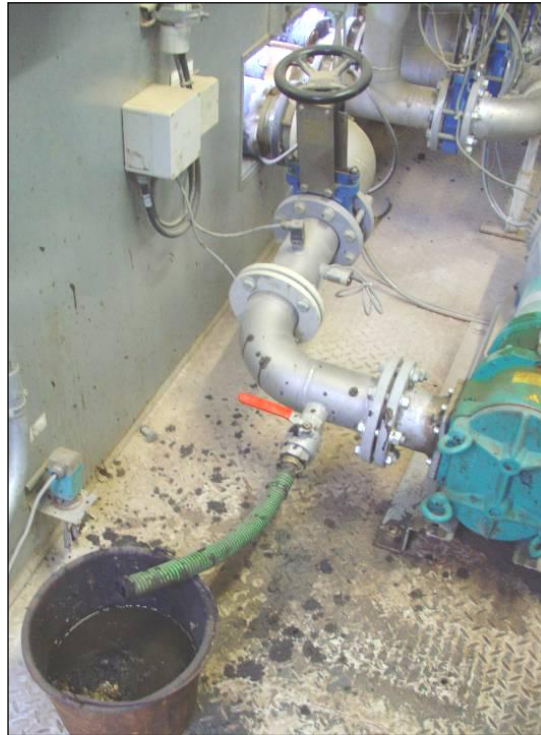
Abbildung 11: Gärrestentnahme über Bypass-Einrichtung. © Bundesgütegemeinschaft Kompost e.V. 2009.
