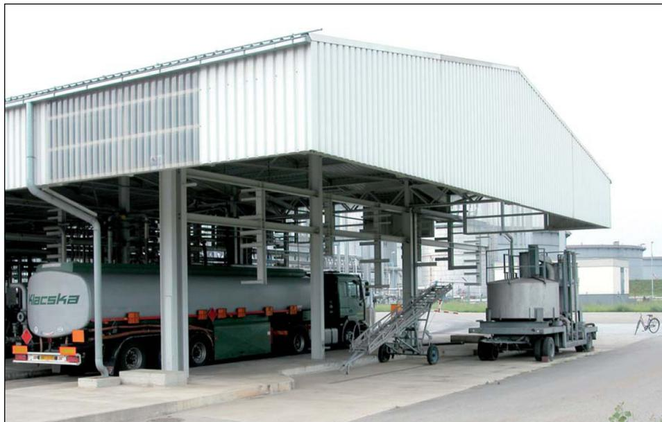
Abbildung 21: Bottom-Loading Ladespur bei OMV-Tanklager St. Valentin. (© SIEMENS 2008).
