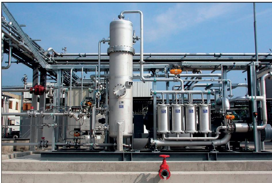
Abbildung 23: Anlagenteil der VRU des Tanklagers Graz zur Verflüssigung von Kohlenwasserstoffdämpfen durch Absorption in einer Füllkörperkolonne. (© OMV 2008).
