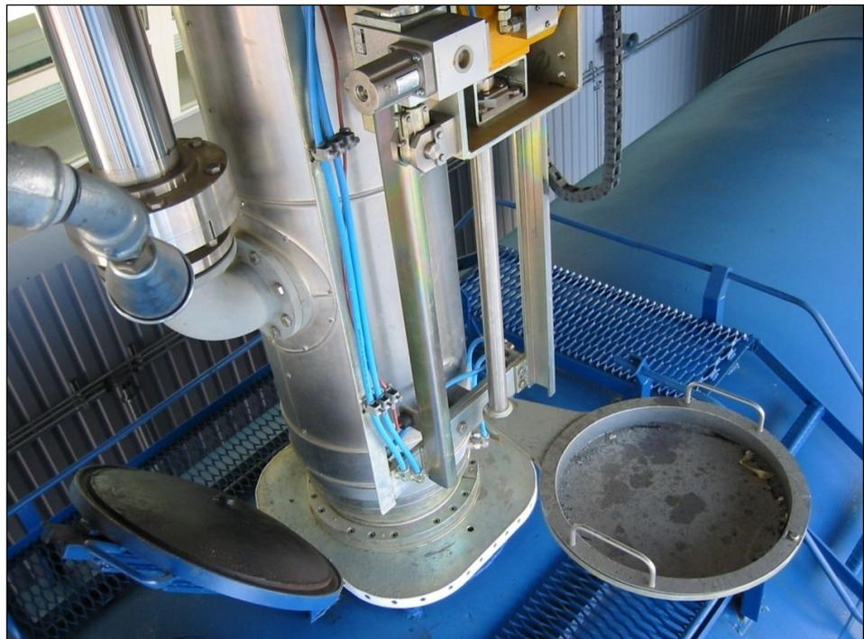
Abbildung 19: Top-Loading-Füllstelle für Kesselwaggons mit konzentrischen Füll- bzw. Gaspindelstutzen: im Bild links ist die Rückführung der beim Füllen entweichenden Produktdämpfe zu sehen. (© SIEMENS 2008).
