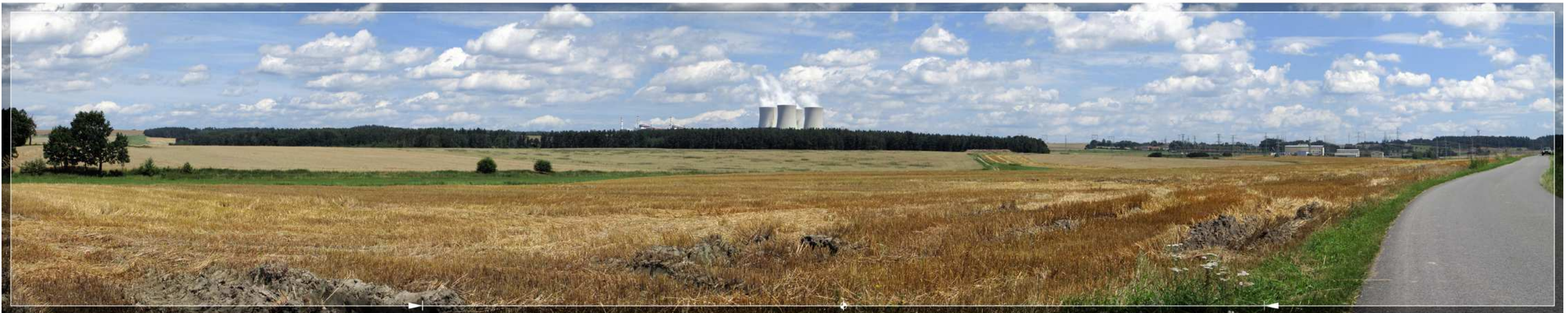
Bild 5.03: Ähnliche Situation wie auf Bild 5.02, hier vom östlichen Rand der Gemeinde Malešice; rechts Umspannwerk Kočín (Blick von SW aus einer Entfernung von 3,6–4,3 km)
