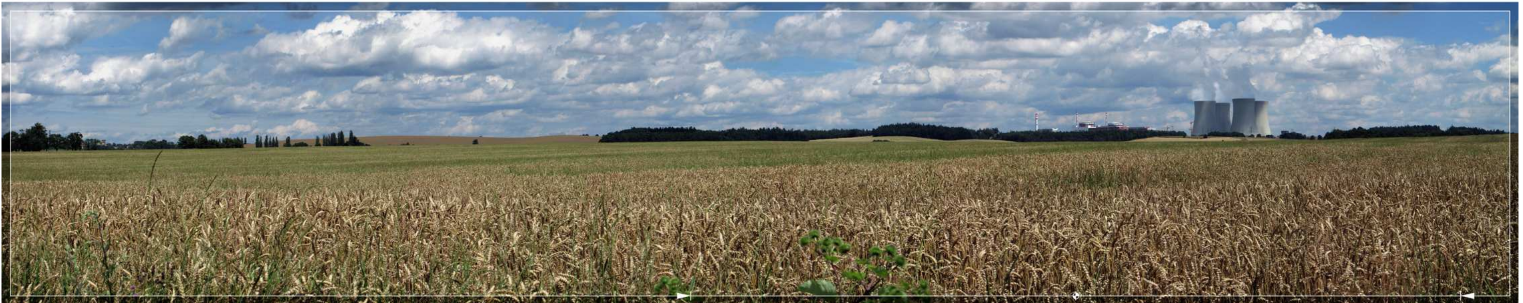
Bild 5.02: Das KKW Temelin als sehr markantes, aber nicht mehr eindeutig landschaftsbestimmendes Landschaftselement der landwirtschaftlichen Landschaft des betroffenen Landschaftsraumes Temelin, Blick vom nordöstlichen Rand der Gemeinde Sedlec (Panorama von W aus einer Entfernung von 3,3–4,1 km)
