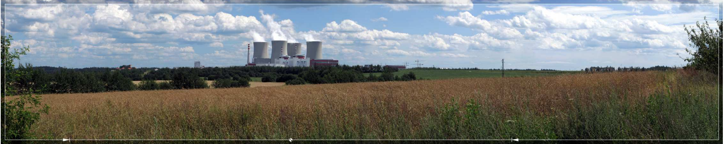
Bild 5.01: Das KKW Temelin als bestimmendes Landschaftselement – betroffener Landschaftsraum Temelin, Panorama von Straße II/141 in der Nähe des nordöstlichen Randes der Gemeinde Temelin (Blick von NW aus einer Entfernung von 2–2,8 km)
