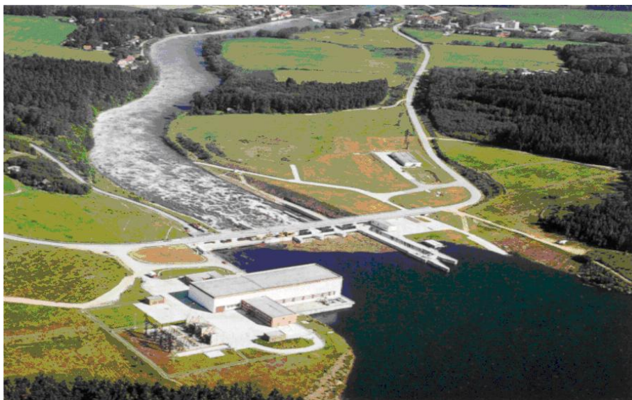
Bild Nr. 16 – Stauanlage Hněvkovice
