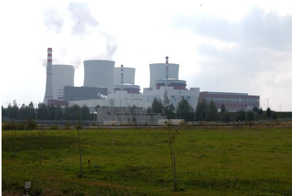
Bild Nr. 1 – Blick von Norden auf das bestehende KKW Temelín 2x1000 MW e
