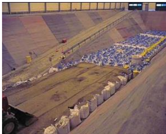
19.3.6-2. ábra: VLLW tároló, Morvilliers, Franciaország [19-27]
