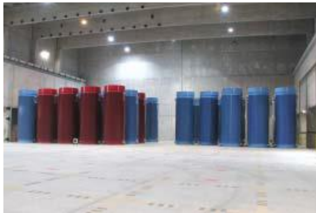
19.4.2-3. ábra: Száraz, konténeres tárolás, csarnokban (CASTOR tartályok, Gorleben, Németország)
