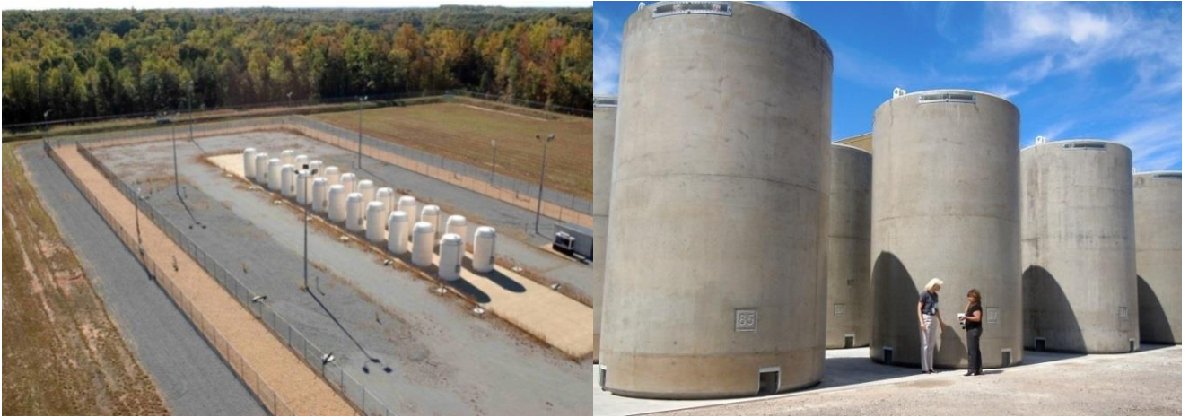
19.4.2-5. ábra: Száraz, konténeres tárolás, függőleges elrendezésben [19-35], [19-36]
