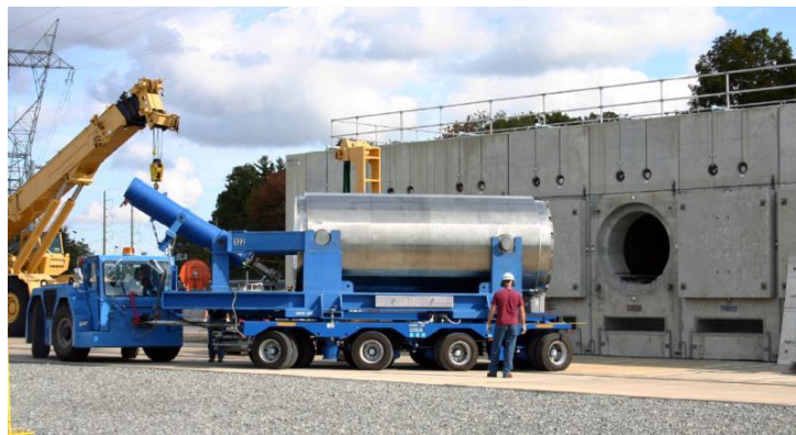
19.4.2-6. ábra: Száraz, vízszintes elrendezésű tároló töltése [19-37], [19-38]
