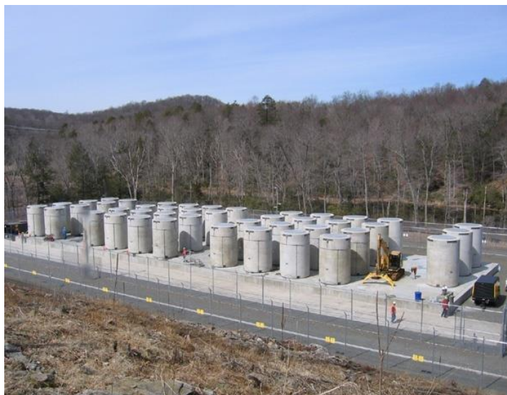
19.4.2-7. ábra: Jellemző elrendezés, száraz konténeres tárolás esetén [19-39]
