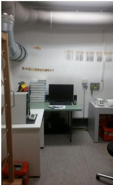
Der Waagraum hat eine Grundfläche von ca 8 m<sup>2</sup> und eine Kubatur von ca. 21,8 m<sup>3</sup>. Die Luftumwälzung zur Einhaltung der Waagraumbedingungen erfolgt durch an der Decke befestigte durchlässige Schläuche eingangseitig, der Luftausgang (d. h. die Rückführung der Luft in das Klimagerät) erfolgt an der Rückwand des Waagraumes in Bodennähe. Das Klimagerät ist im Nebenraum installiert.
