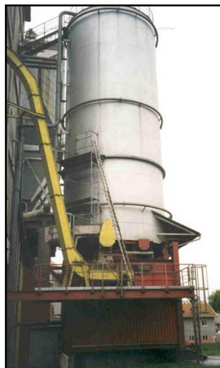
Abbildung 21: Übernahmestelle und Silo für Ersatzbrennstoffe
