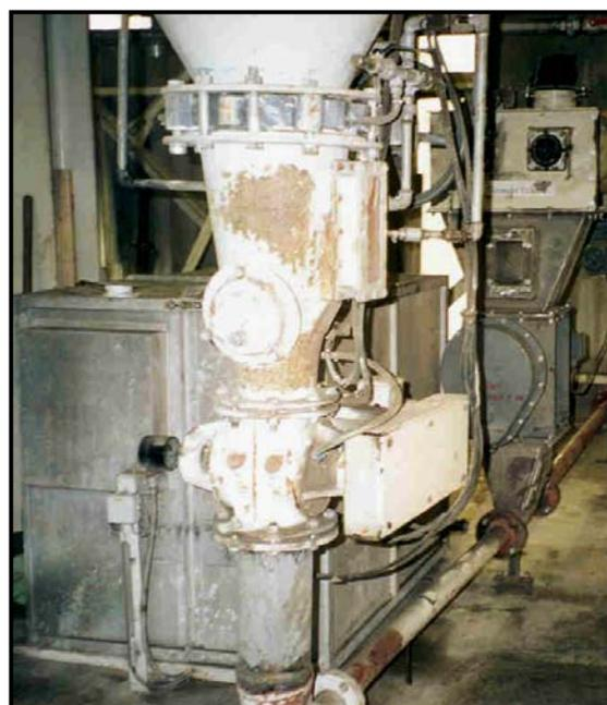
Abbildung 30: Dosiervorrichtung unterhalb des Tiermehl- bzw. Aschesilos
