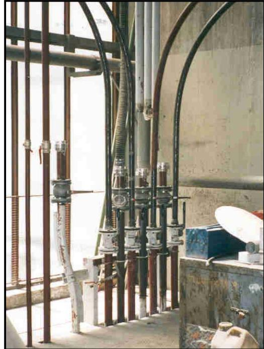
Abbildung 26: Tiermehlförderleitungen – von den Silos zu den Brennern
