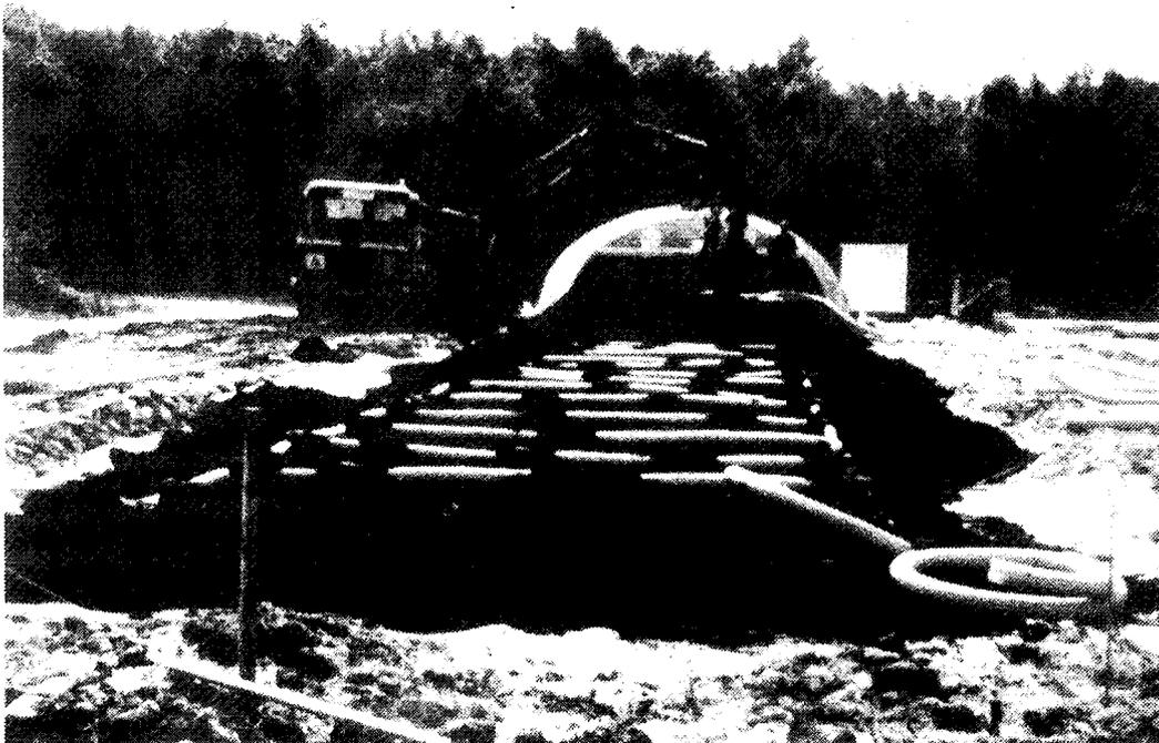
**Bild 11:** Aufbau der Regenerationsmieten in HDPE-Wannen mit horizontal verlegtem Belüftungssystem (Unterdruck).
