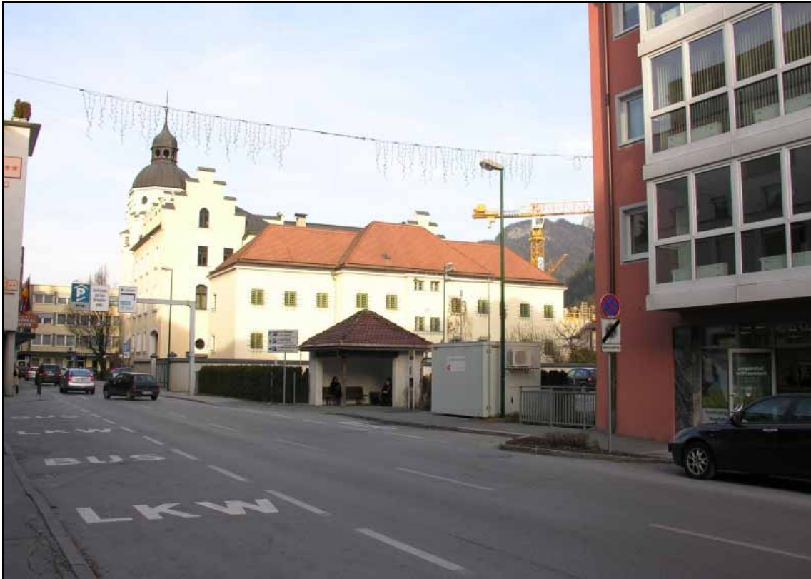
Figure 8: Detached buildings, Kufstein Praxmarerstraße, Tyrol, Austria (source: Amt der Tiroler Landesregierung).
