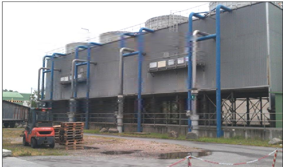
Die Kühltürme sind auch im Winter im Betrieb, da das Kühlwasser verglichen mit der Einlauftemperatur nur um 10 °C erwärmt werden darf. Aus diesem Grund kommt es an den Kühltürmen zu einer starken Bildung von Eis, die immer wieder zu einer Beschädigung der Einbauten führt.
