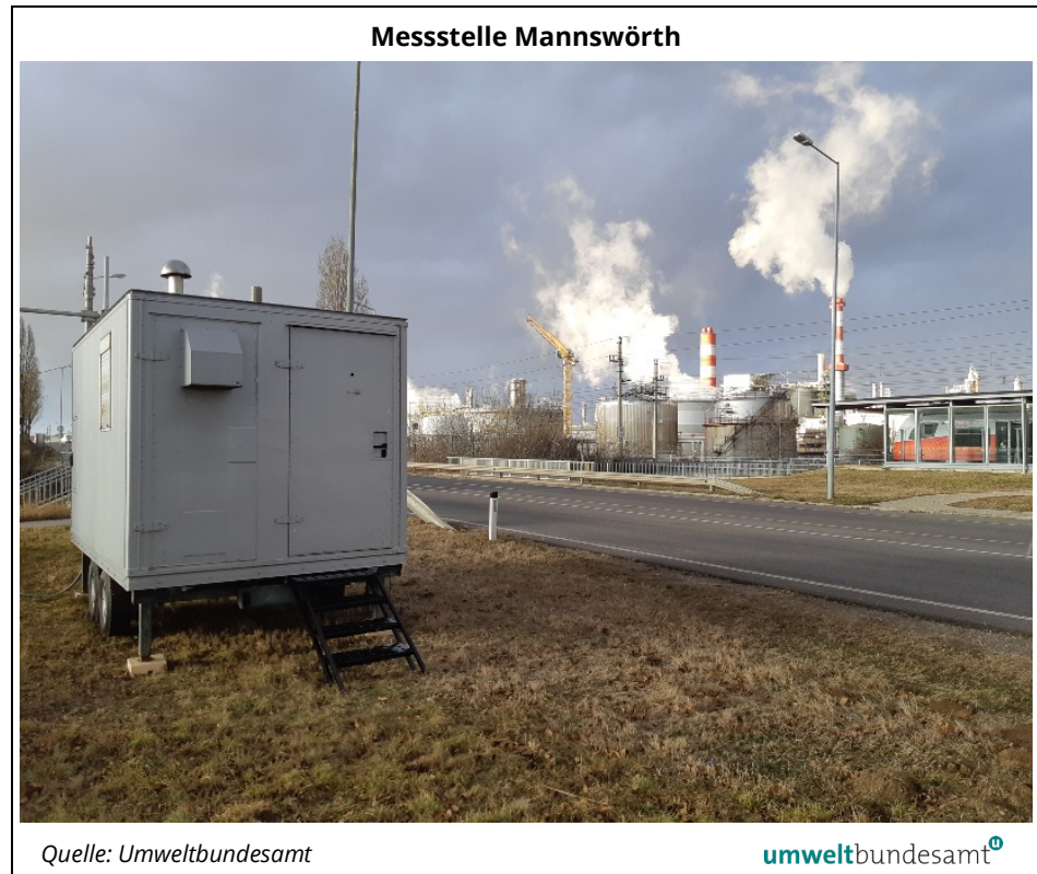
Abbildung 20: Messstelle Mannswörth Umspannwerk von Südosten (Raffinerie im Hintergrund).
