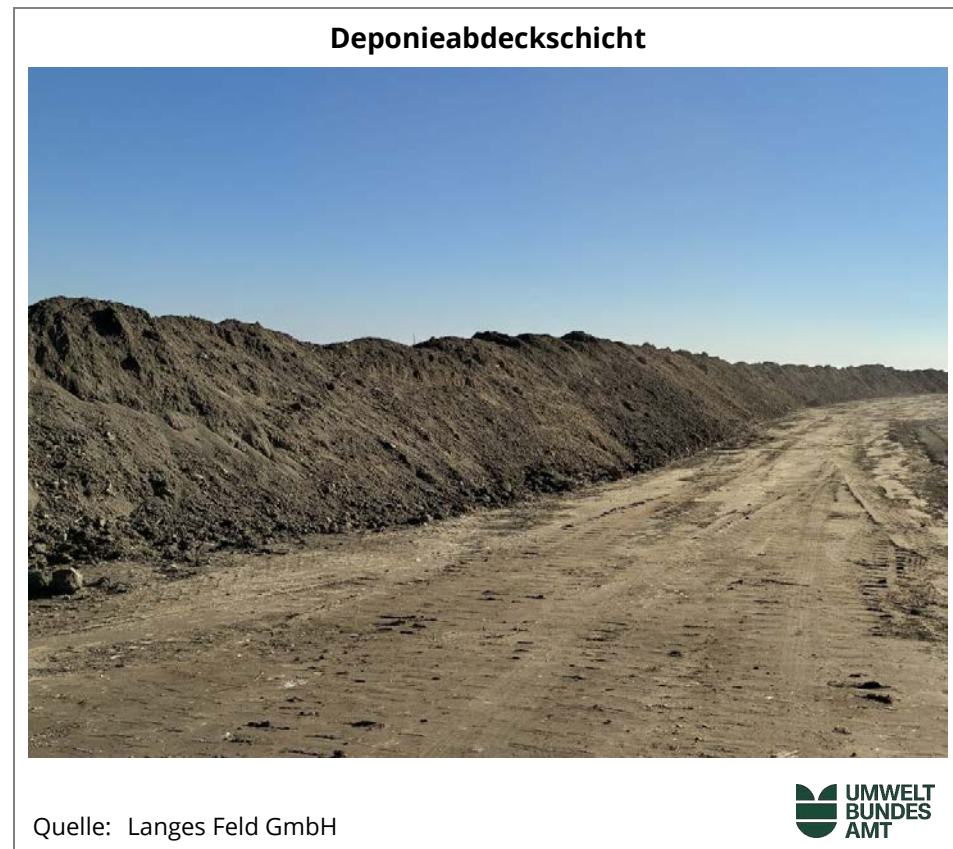
Abbildung 3: Deponieabdeckschicht im Aufbau unter Verwendung kulturfähiger Erde. (© Langes Feld GmbH)
