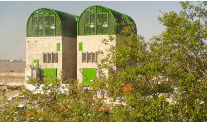
Dieselbetriebene letzte Notstromaggregate (DUS) von 3 MWe
