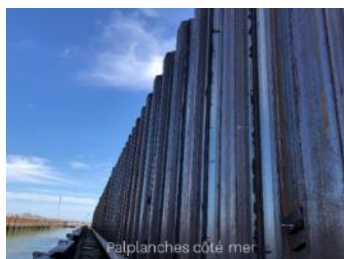
Palplanches côté mer
