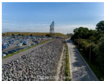
Digue côté terre
