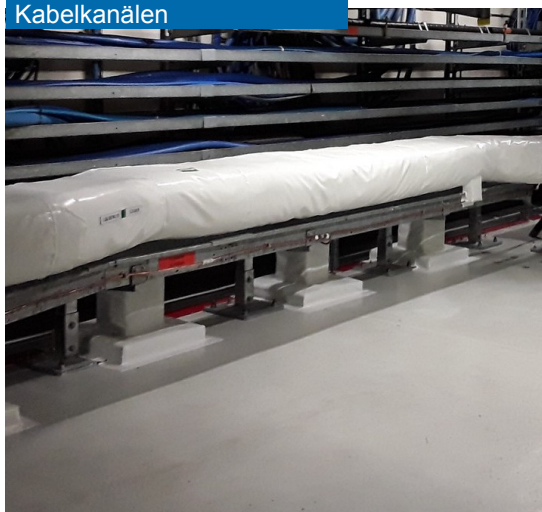
Beispiel für den Schutz von Kabelkanälen
