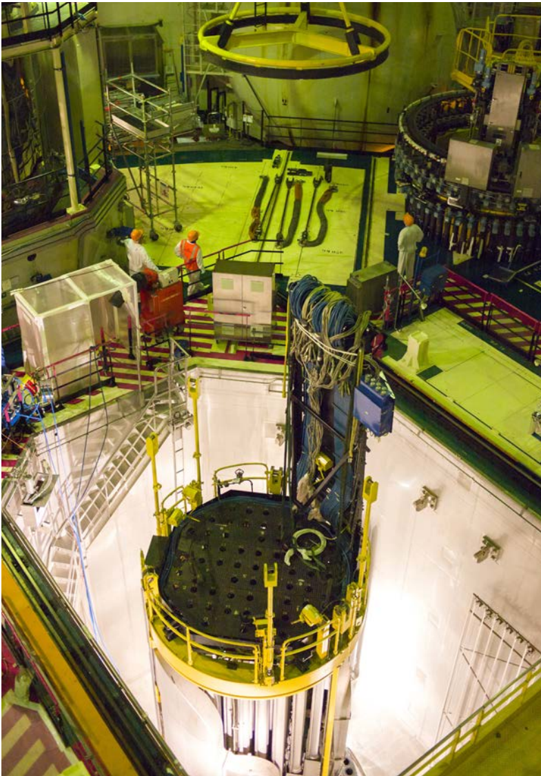
Pose du couvercle de cuve du réacteur au Centre Nucléaire de Production d'Électricité de Cruas-Meysses.
