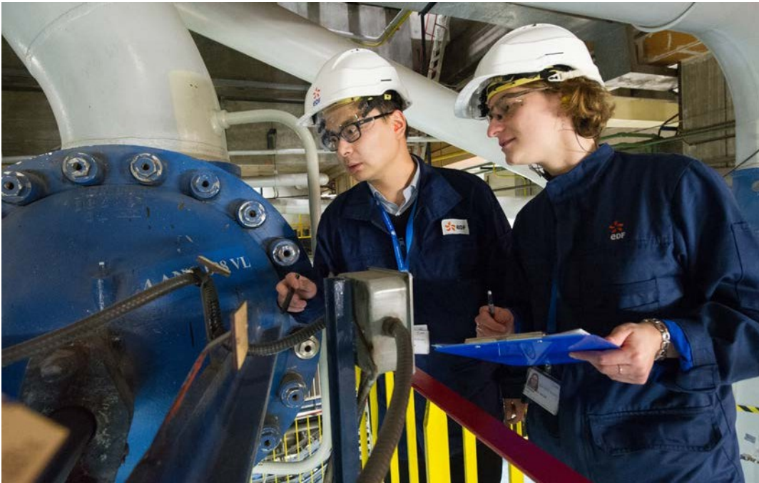
Techniker bei der Inspektion im Reaktorraum der „Anlagen im Kernkraftwerk der Stromerzeugung in Вуоуу.
