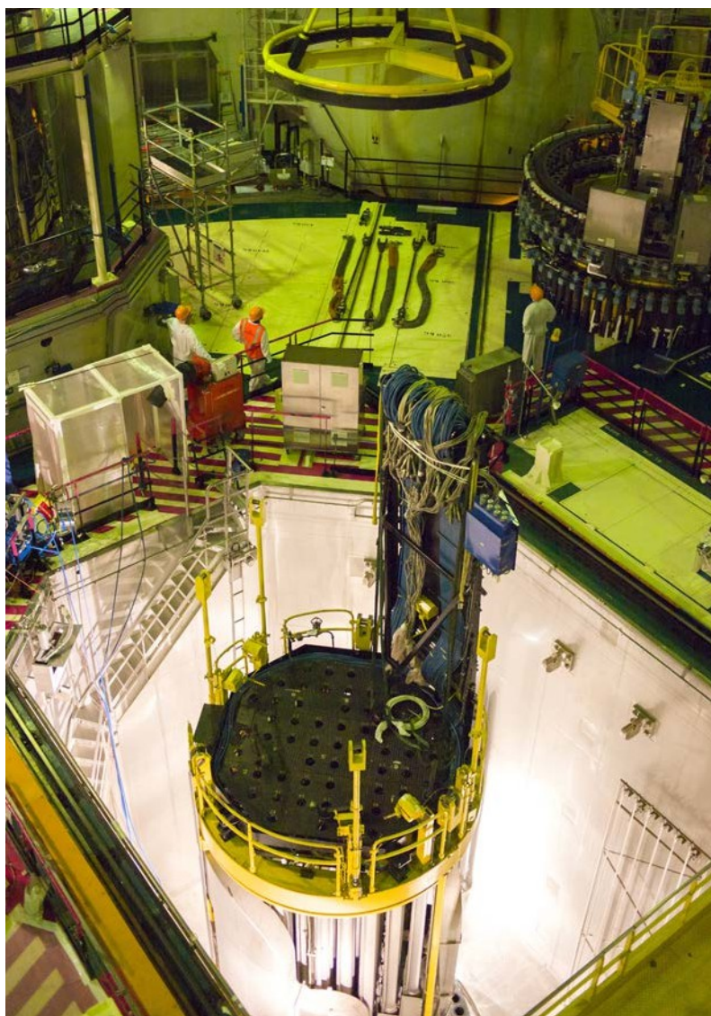
Posc des Reaktordeckels im Kernkraftwerk Cruas-Maysac.
