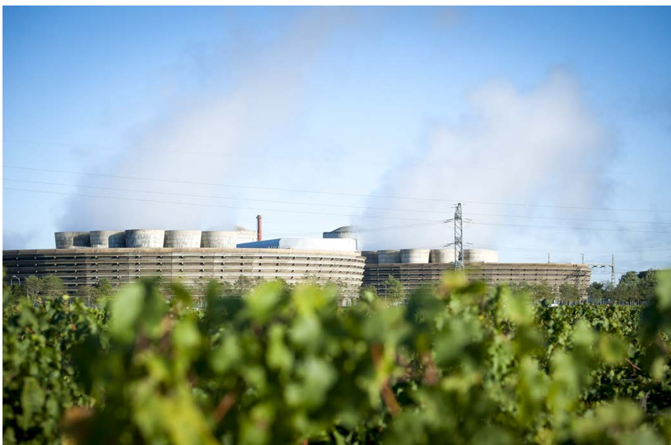
Centre Nucléaire de Production d'Électricité de Chinon.
