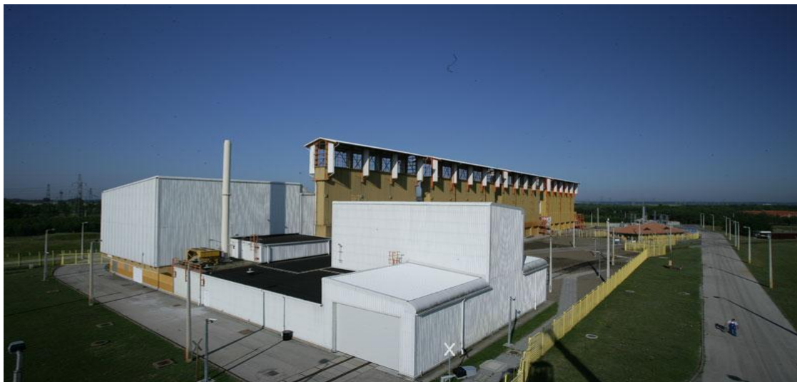
Bild 8 Zwischenlager in der Kernkraftanlage Paks (RHK, 2009)
