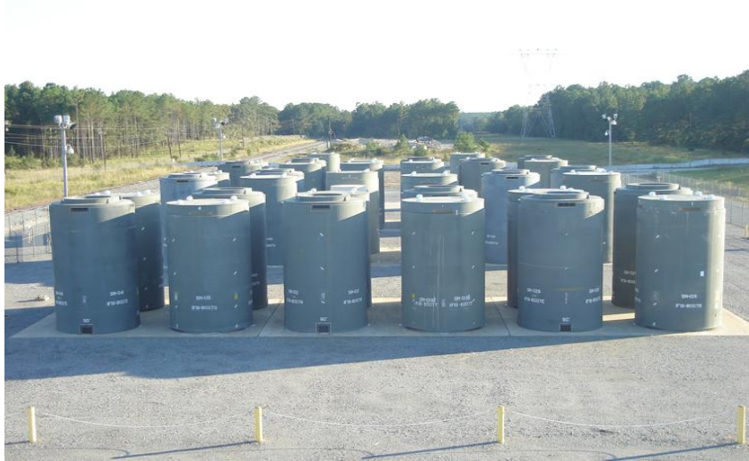
Bild 32 HI-STORM 100 in ASCO NPP (Holtec, 2013)
