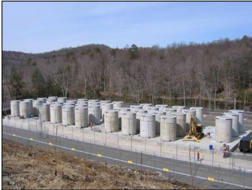
Bild 30 NAC MPC-System in YANKEE ISFSI (Hoedeman, 2008)
