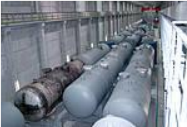
ZLN - Halle 7 mit Dampferzeuger aus den KKW-Blöcken
