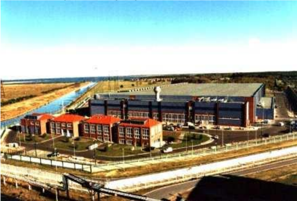
Gesamtansicht auf Integral-Repository Nord EWN Deutschland
