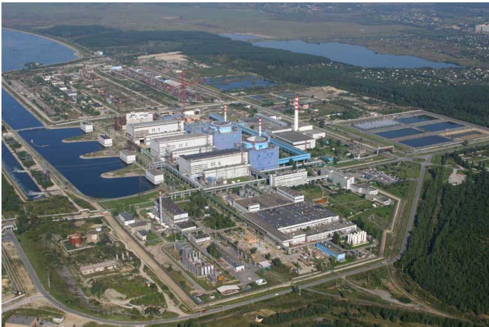
Рисунок А.2 – Общий вид промплощадки ОП ХАЭС
