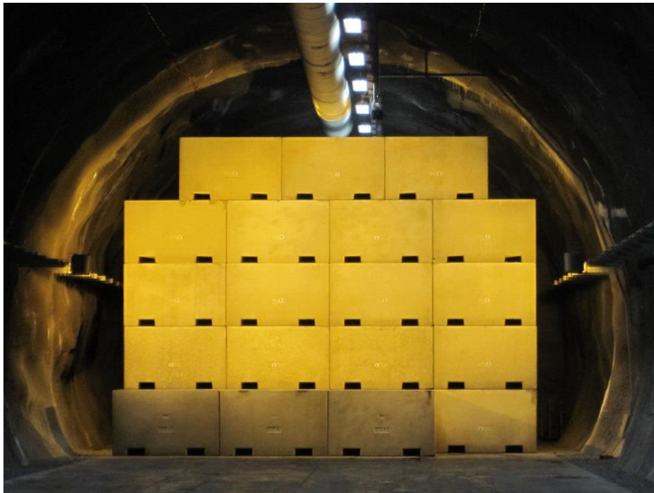
Abbildung 19: Unterbringung von Stahlbetoncontainern in der Lagerkammer I-K1 des NRHT
