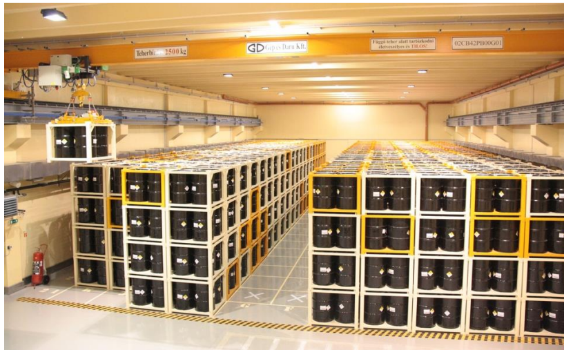
Abbildung 18: Technologische Lagerung der radioaktiven Abfälle in der oberirdischen Anlage des NRHT
