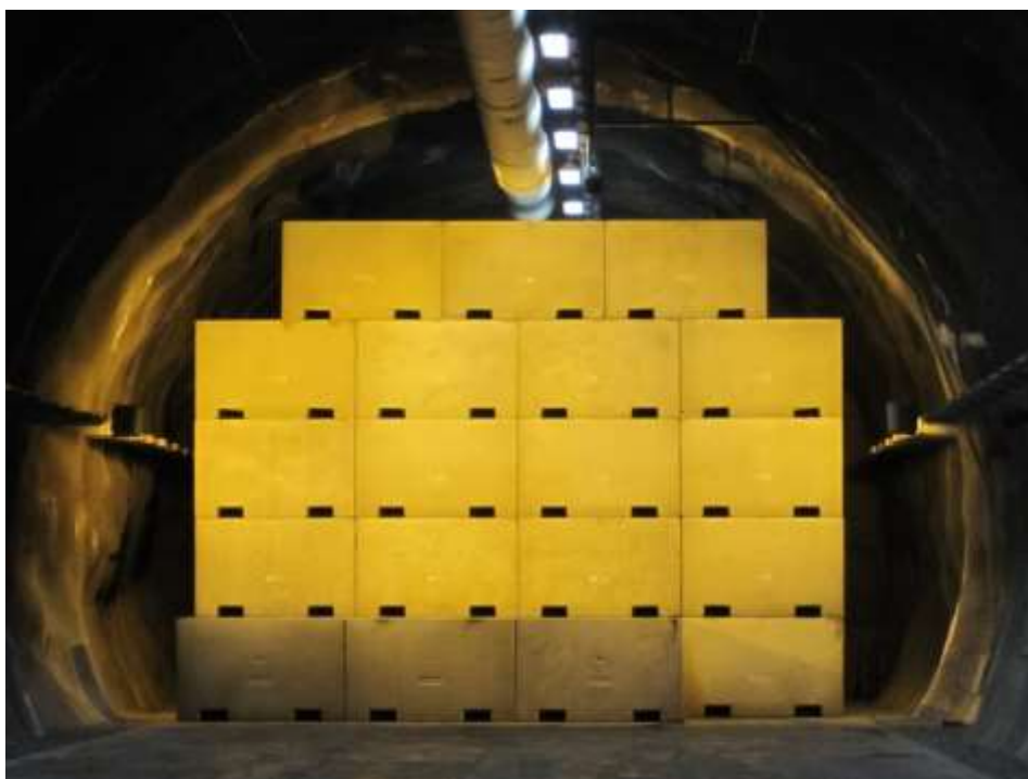
Abbildung 15: Unterbringung von Stahlbetoncontainern in der Lagerkammer I-K1 des NRHT
