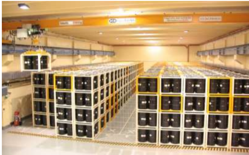
Abbildung 14: Technologische Lagerung der radioaktiven Abfälle in der oberirdischen Anlage des NRHT
