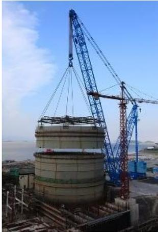
**Abbildung 2.4.4.1-1.: Einsetzen des 3. Containment-Ringes in Sanmen 1.**
