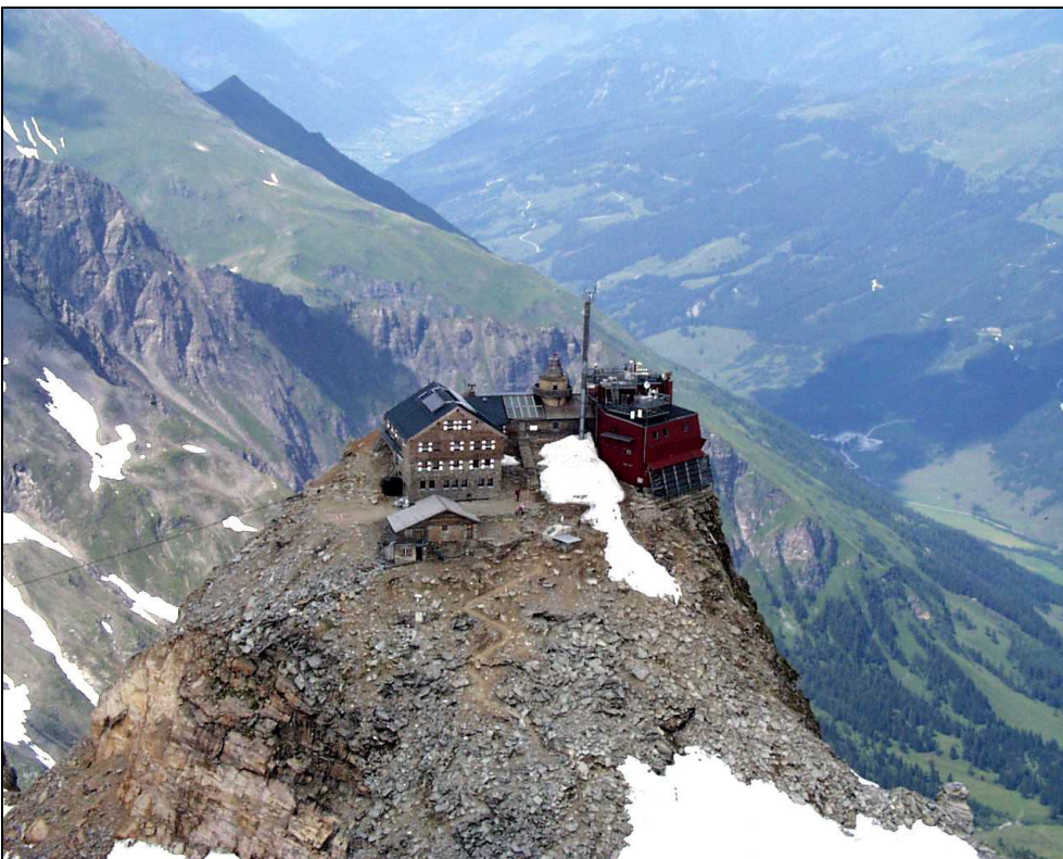
Abbildung 7: Messstelle Sonnblick von Süden (© ZAMG, Staudinger).
